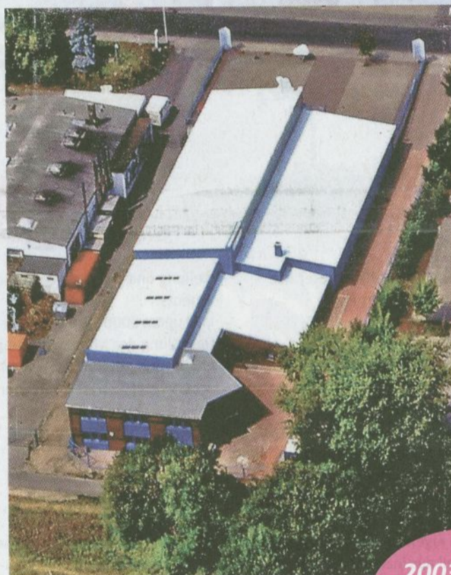
Nach dem Anbau 2003
